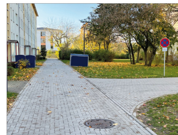
Straßensanierung im Vergleich: vorher-nachher
